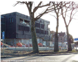
Toegang ondergronds parkeergarage in de Westluidense Poort
